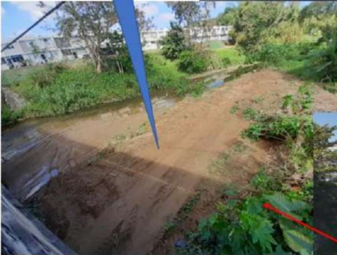
Trabajos resientes en la franja del Río que colinda con las casas del proyecto.
