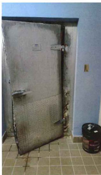
CHARCO A CAUSA DE FILTRACIONES DE PARED
