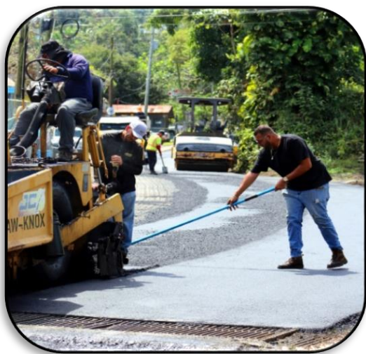
Figura 65: Asfalto en el Barrio Camarones
