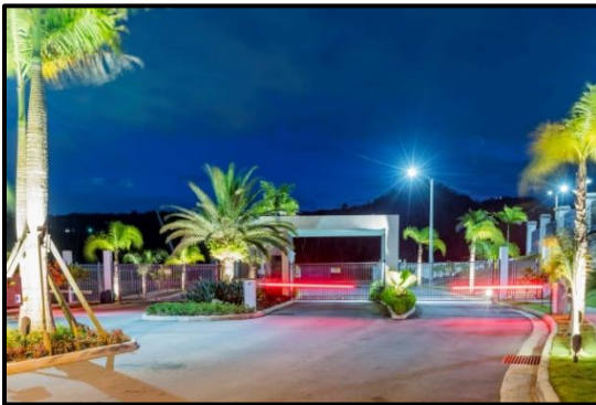
Control de acceso - Urb. Belmont
