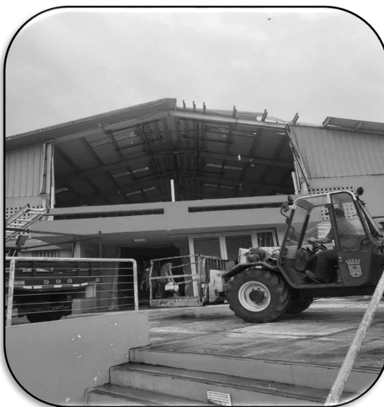
Figura 64: Reparaciones al Complejo Deportivo Moisés García, Año 2017
