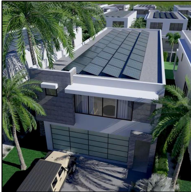
Figura 47: Sistema de placas solares en el proyecto de vivienda Solaris
