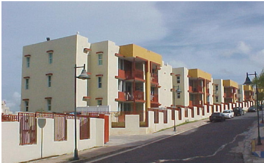
Portal de Sofía, otro grupo de viviendas construido por la empresa privada.
