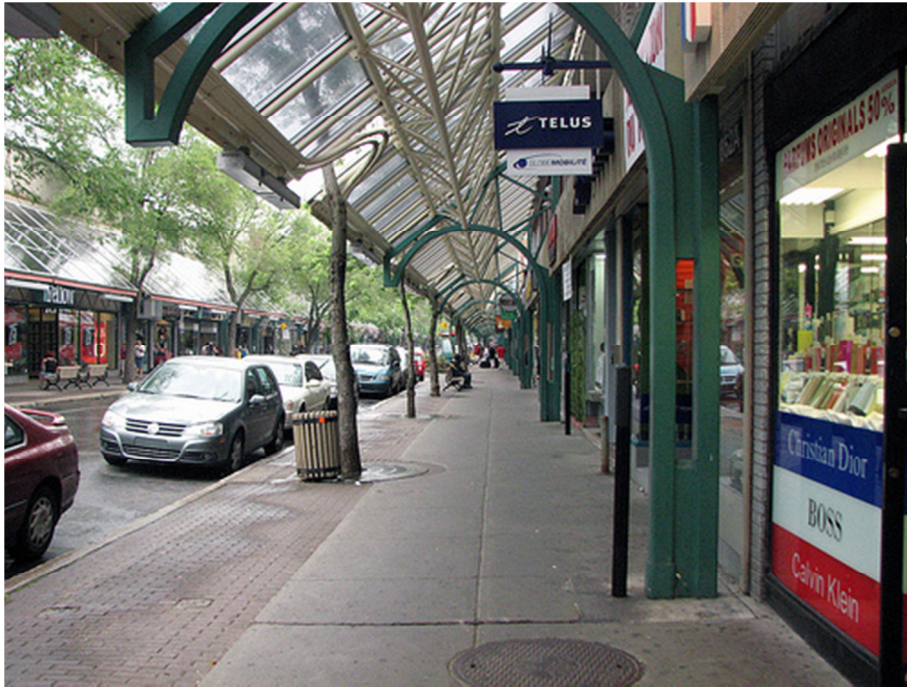
Figura 32: Ejemplo de estructura para cubrir parcialmente las aceras. (Rue St. Hubert, Montreal Canada)
